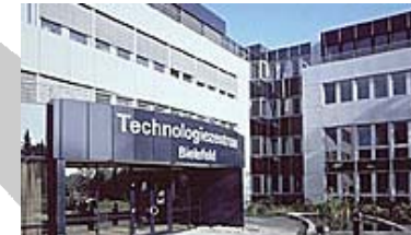
Regionalbüro Bielefeld im Technologiezentrum
